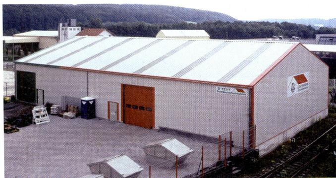
Mobile Hallen im Leichtbau. Die Haltec Hallensysteme GmbH im westfälischen Hemer verwendet Stahlgerüste, die Wände sind aus Blech oder Zeltstoff.
