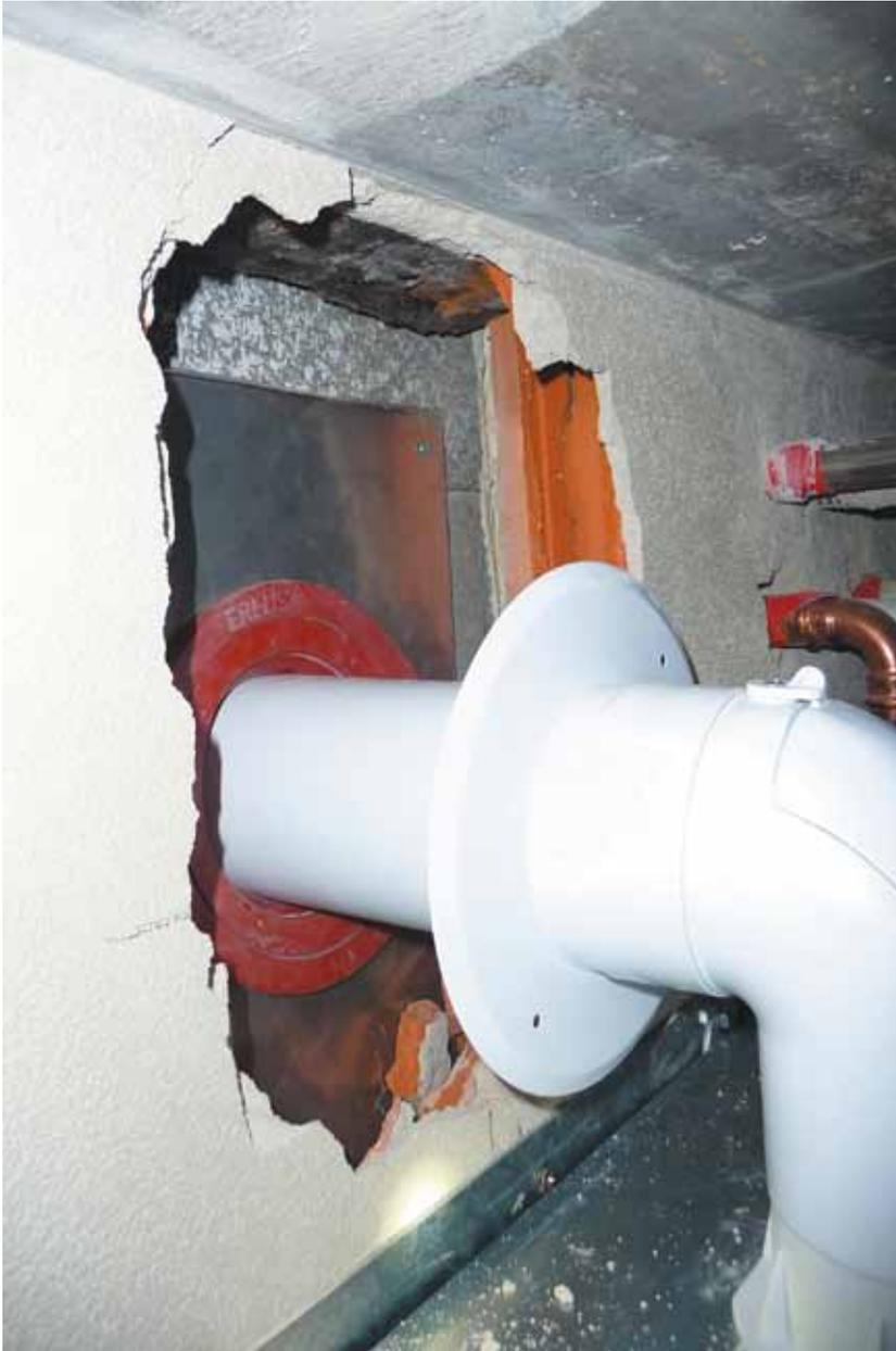
**Abb. 4.23:** Der Wandanschluss des Rohr-in-Rohr-Systems einer Gasbrennwerttherme wird wie durchgebrochen hinterlassen.
