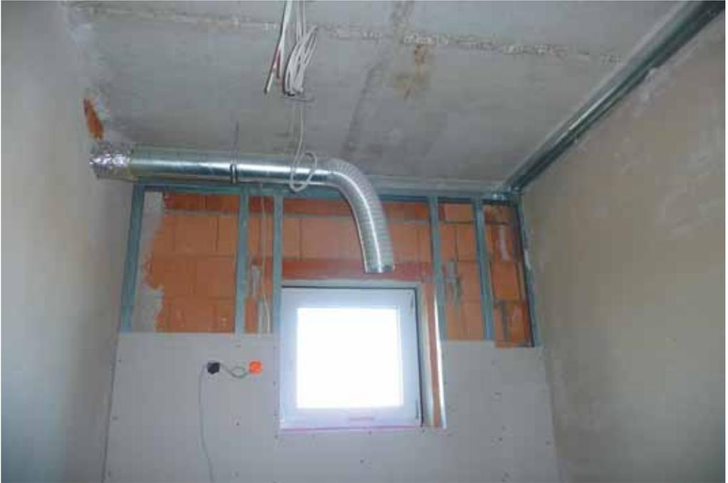
**Abb. 4.9:** Durch Gipskartonvorbauten lässt sich unverputztes Mauerwerk nicht abdichten.
