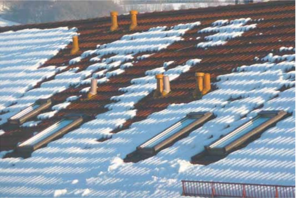
**Abb. 4.5:** Dachlandschaft mit unnötig vielen Entlüftern, die nicht fachgerecht eingebaut worden sind – austretende Warmluft taut das Dach großflächig ab.
