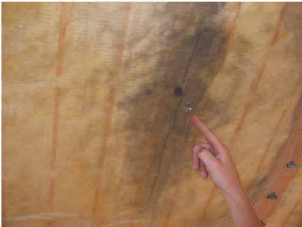
**Abb. 4.63:** Durch eine kleine Beschädigung in der Dampfsperre tritt während der Heizperiode ständig Raumluft durch die Mineralwolldämmung, die alle Schwebstoffe wie ein Staubsaugerbeutel aufammelt.
