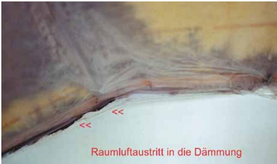
**Abb. 4.59:** Durch nicht fachgerechten Anschluss der Dampfsperrebahn an den Putz wird die Dämmung von warmer Raumluft durchströmt und so mit der Zeit schwarz wie ein Staubsaugerbeutel innen.
