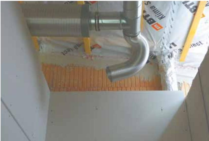
**Abb. 4.18:** Unverputzte Ziegelwände werden auch durch vorgestellte Trockenbaukonstruktionen nicht mehr dicht – es zieht dann später durch alle Ritzen und Anschlussfugen.
