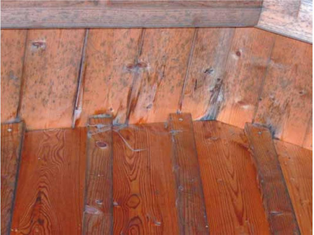
**Abb. 4.58:** Dachüberstand im Firstbereich; durch Leckagen strömt Raumluft nach außen. Dies hat an der Dachuntersicht bereits zu Feuchtespuren und Schimmel geführt.
