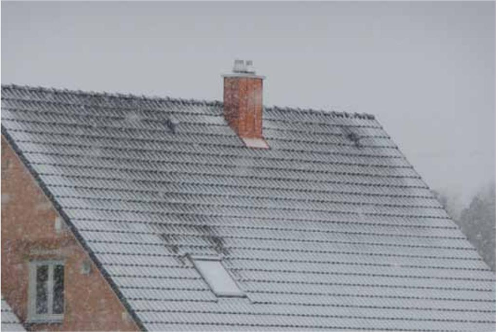
**Abb. 4.6:** Ein Neubau bei Schneefall: Beginnende Abtauvorgänge zeigen den Austritt von warmer Raumluft durch die Dachkonstruktion an.
