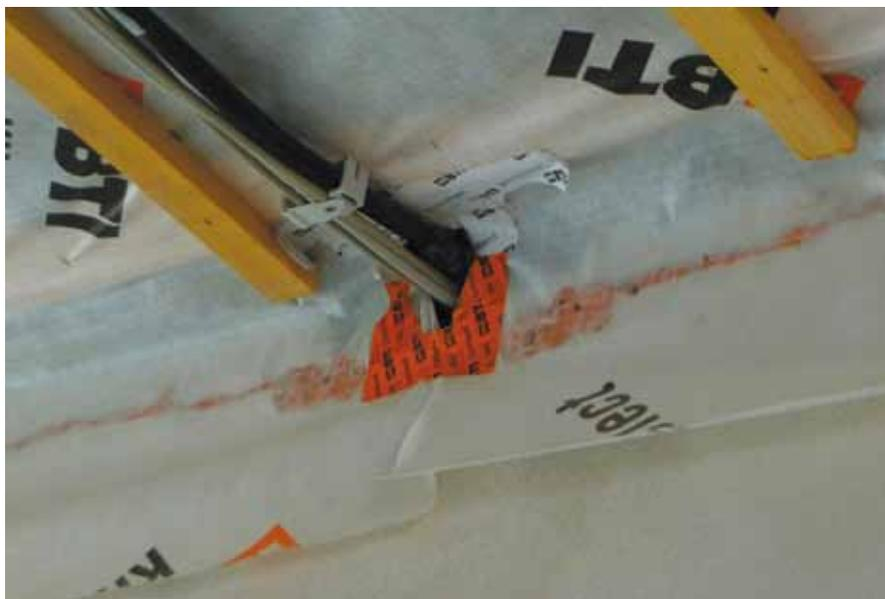
**Abb. 4.19:** Hier hat ein Elektriker beim Durchführen von Leitungen die luftdichte Ebene zerstört.
