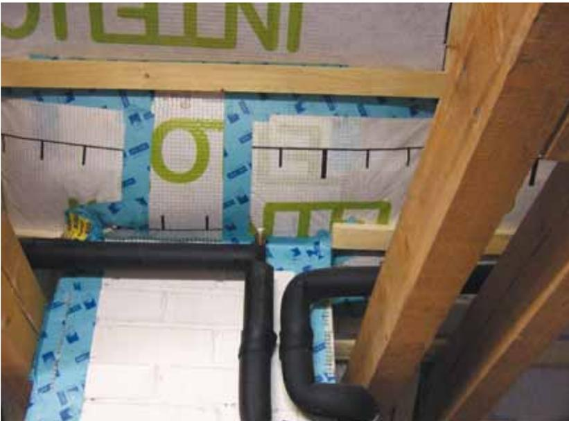
**Abb. 4.21:** Installationen wie diese gedämmten Rohrleitungen werden sinnvollerweise vor der Luftdichtheitsebene ausgeführt.
