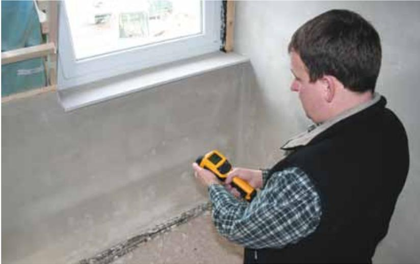
**Abb. 4.12:** Bei baubegleitenden Luftdichtheits tests geht es nicht um das Einhalten aktueller Grenzwerte, sondern darum, Luftlecks in der Gebäudehülle aufzuspüren. (Foto: FLiB e. V.)
