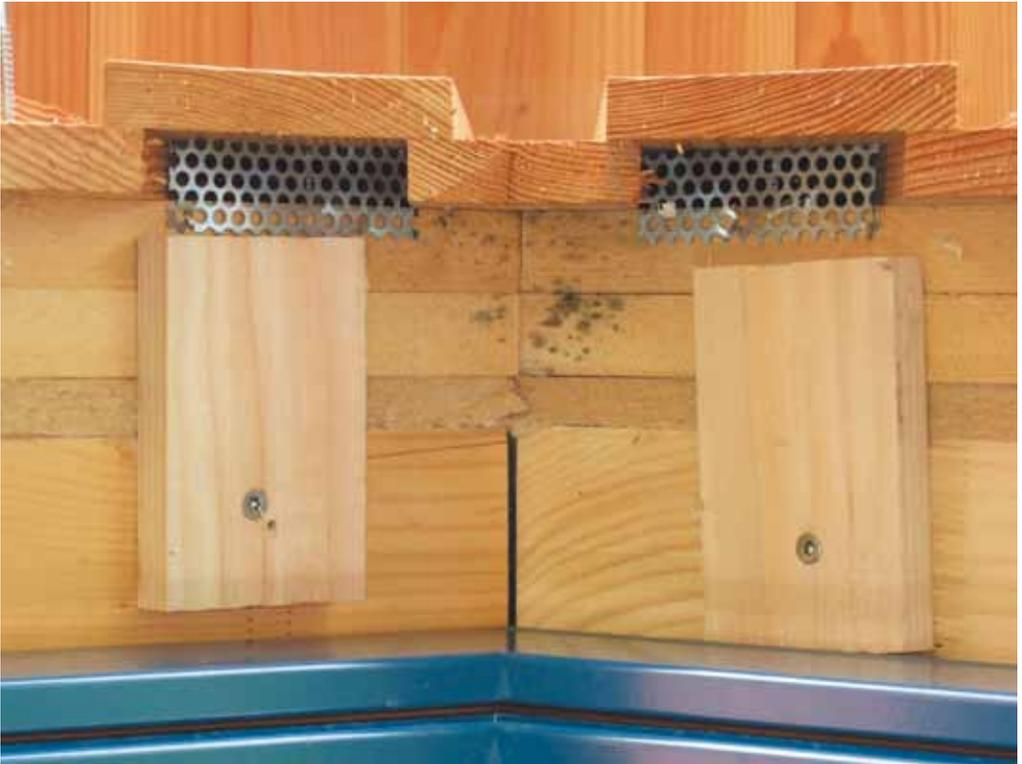
**Abb. 4.61:** Beginnender Schimmel in der Laibung über einem Fenster weist auf die undichte Ausführung von Bauteilanschlüssen hin.
