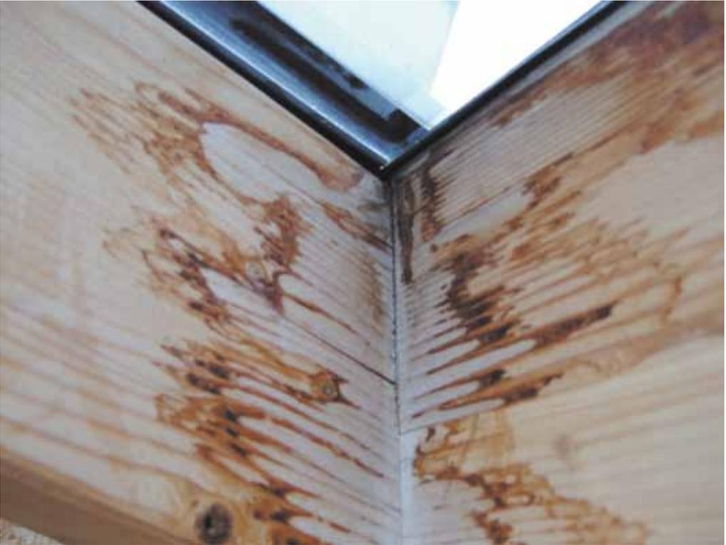
**Abb. 4.54:** Untere Ecke einer Festverglasung: Durch fortgesetzte Benetzung durch herablaufendes Kondensat hat das Sichtholz stark gelitten.
