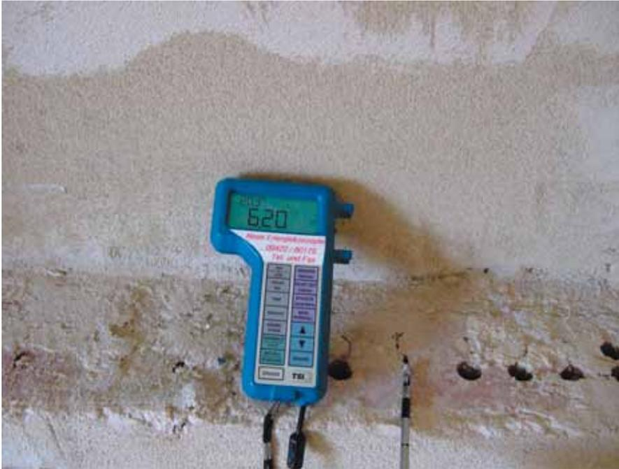
**Abb. 4.68:** Lochziegelkronen können durch ein abschließendes Mörtelband luftdicht geschlossen werden.
