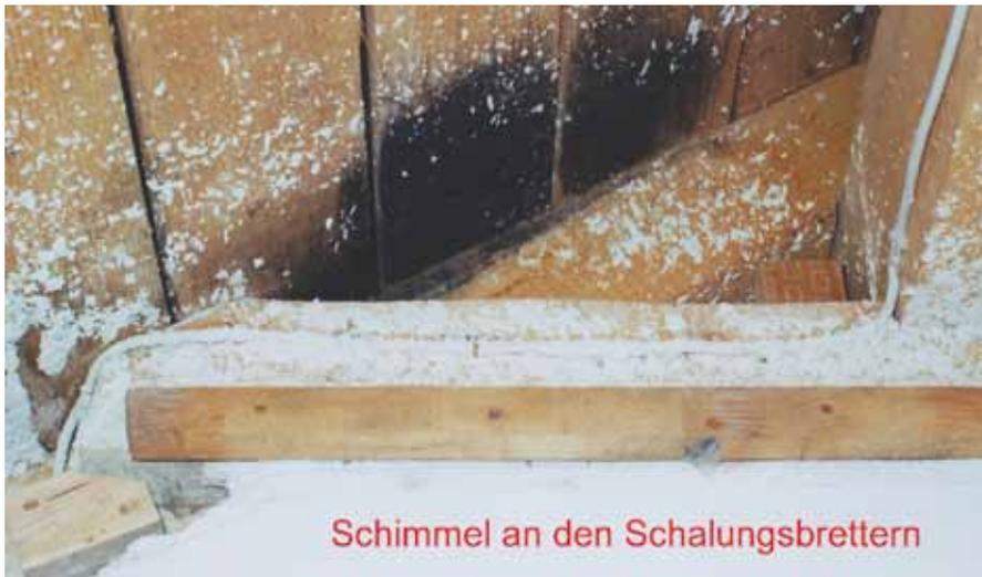
**Abb. 4.60:** Nach dem Öffnen der Decke wurde sichtbar, dass durch austretende Raumluft und somit ständige Befeuchtung der kalten Schalungsbretter des Dachs schwarzer Schimmel gewachsen ist.
