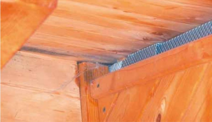
**Abb. 4.56:** Austretende Raumluft hat in der Bildmitte bereits Feuchte- und Schimmelspuren hinterlassen.
