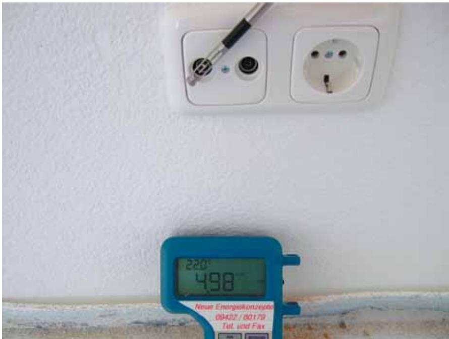
**Abb. 4.67:** Luftdurchströmte Steckdosen im Ziegelmauerwerk: Es ist besser, in den Außenwänden luftdichte UP-Dosen zu verbauen, um solche Zugerscheinungen zu verhindern.
