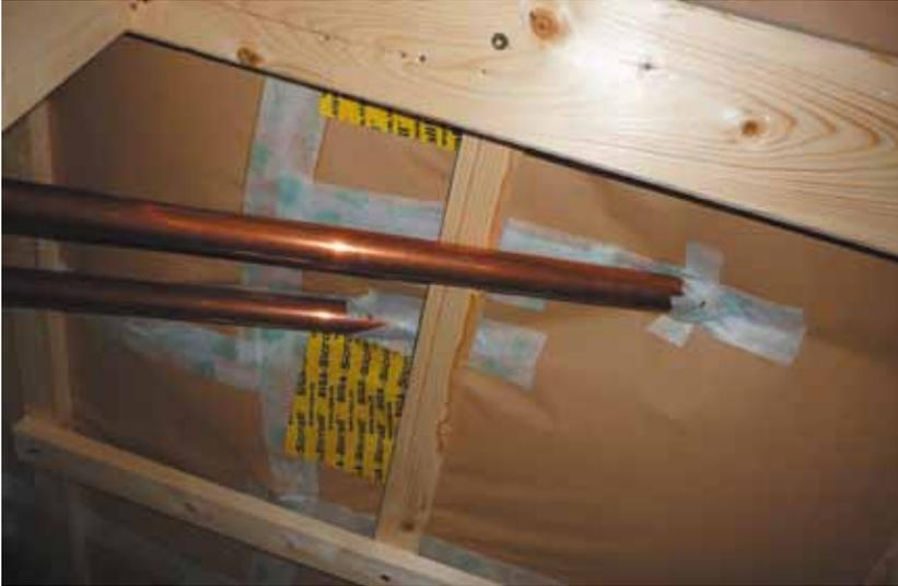
**Abb. 4.20:** Das kann auf die Dauer nicht gut gehen: Rohre der Solaranlage werden bis über 100 °C heiß. Lange machen das die nicht hitzebeständigen Klebestreifen nicht mit.
