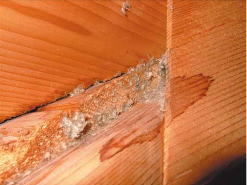
**Abb. 4.52:** Wasserspuren an Hölzern im Dach sind ein Hinweis darauf, dass unkontrolliert Raumluft in die Konstruktion austritt und dort bei Kälte kondensiert.
