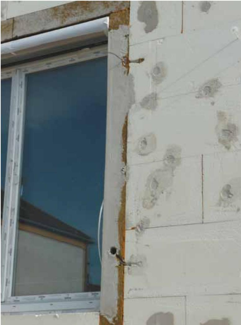
**Abb. 4.3:** Fachgerecht über die Fensterlaibung bis an den Fensterstock geführte Wärmedämmung
