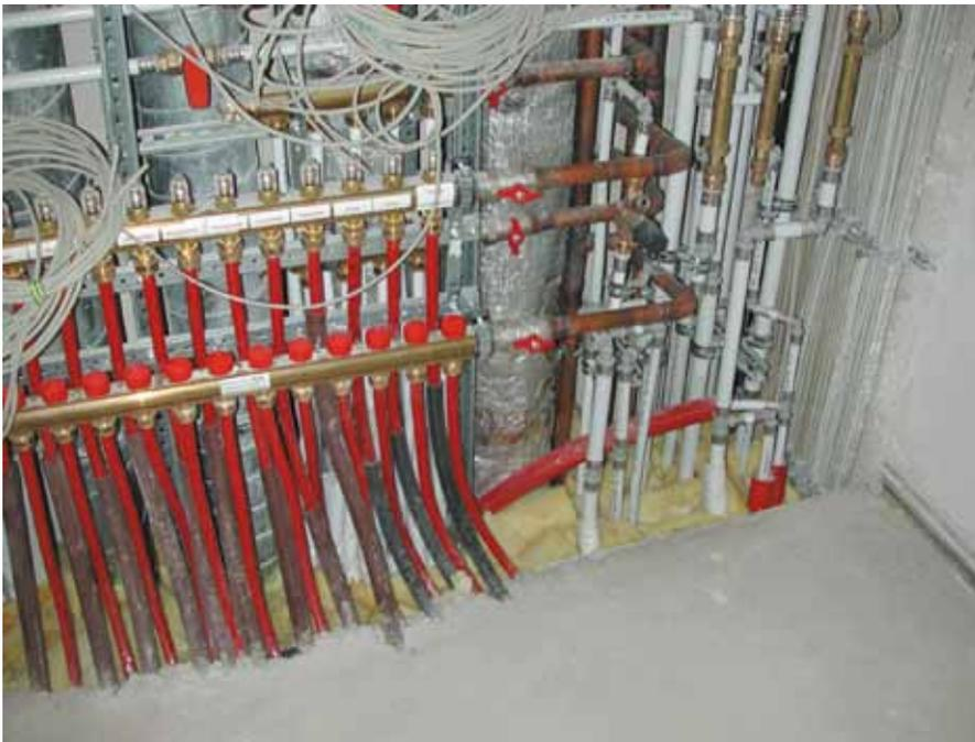
**Abb. 4.15:** Luftdicht durch eine Geschossdecke geführte Kabel und Rohre (Foto: FLiB e. V.)
