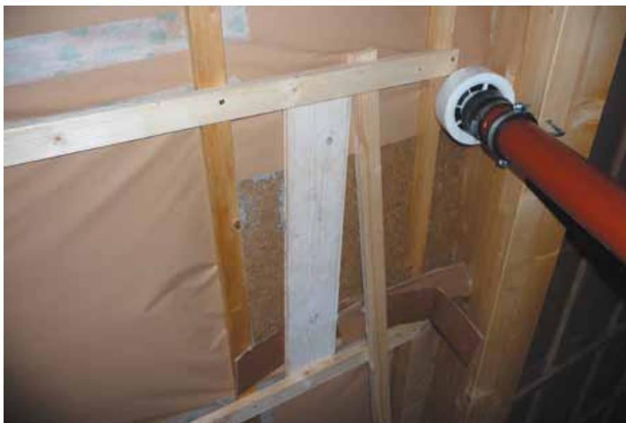
**Abb. 4.16:** Hier hat die braune Dampfbremse nicht ganz gereicht. Es folgte der missglückte Versuch, das verbliebene Loch mit einem Brett und Pappstreifen zu verschließen.
