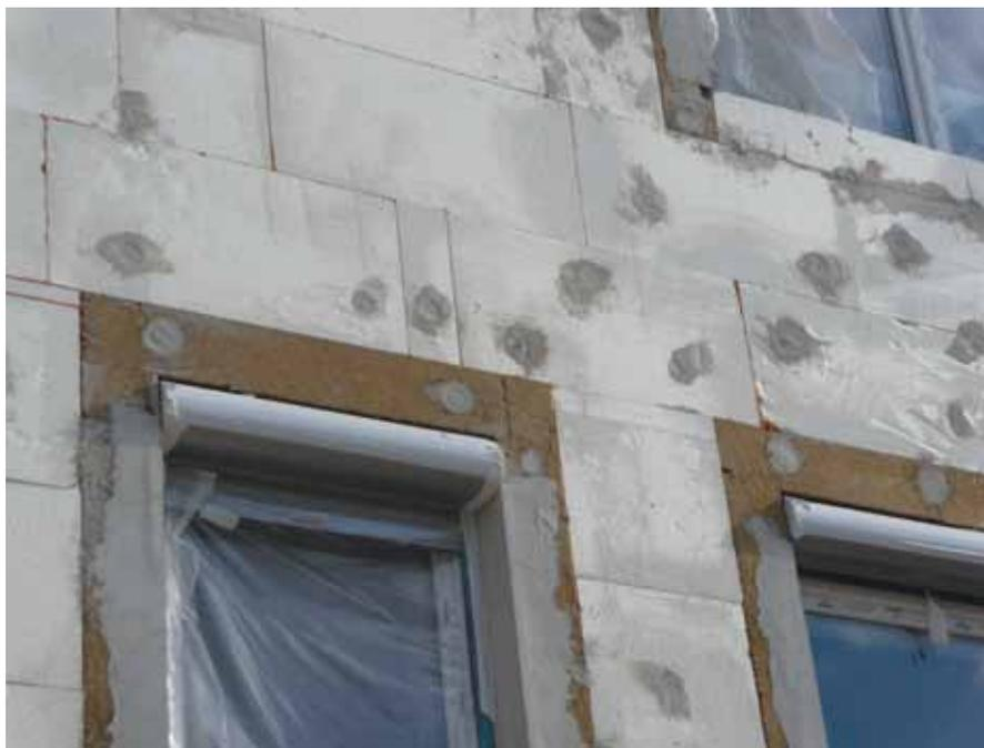
**Abb. 4.4:** Die Wärmedämmung ist lückenlos über die Fensterlaibung bis auf den Fensterstock geführt. Um Rissbildung im Putz zu vermeiden, wird zuerst eine Putzschicht mit eingearbeitetem Putzgewebe aufgetragen, auf die als zweite Lage der Oberputz folgt.
