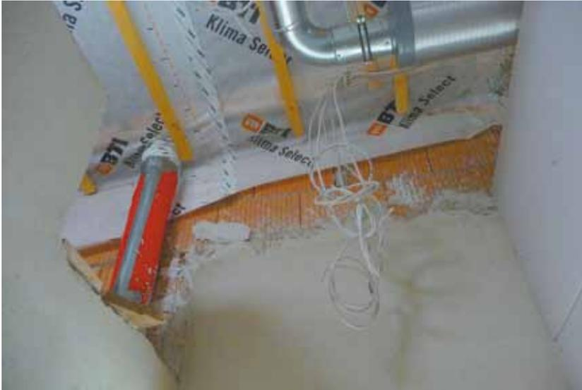
**Abb. 4.17:** Die Dampfbremsbahn wurde an unverputztes Mauerwerk geklebt. Raumluft hinterströmt diese nicht fachgerechte Ausführung durch die vertikalen Rillen und Stoßfugen der Ziegel.
