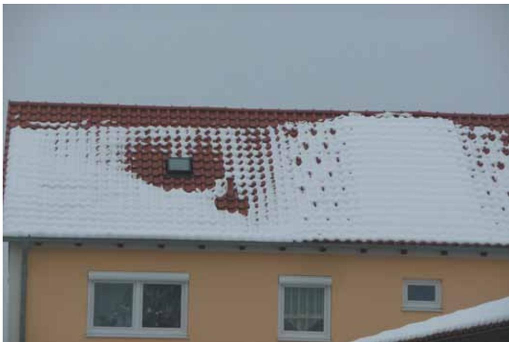
**Abb. 4.8:** Trotz Sanierung: Über dem ungeheizten Treppenhaus (rechts) bleibt der Schnee liegen, über dem beheizten Wohnraum (links) sind nach der Dachsanierung massive Ausführungsfehler erkennbar.
