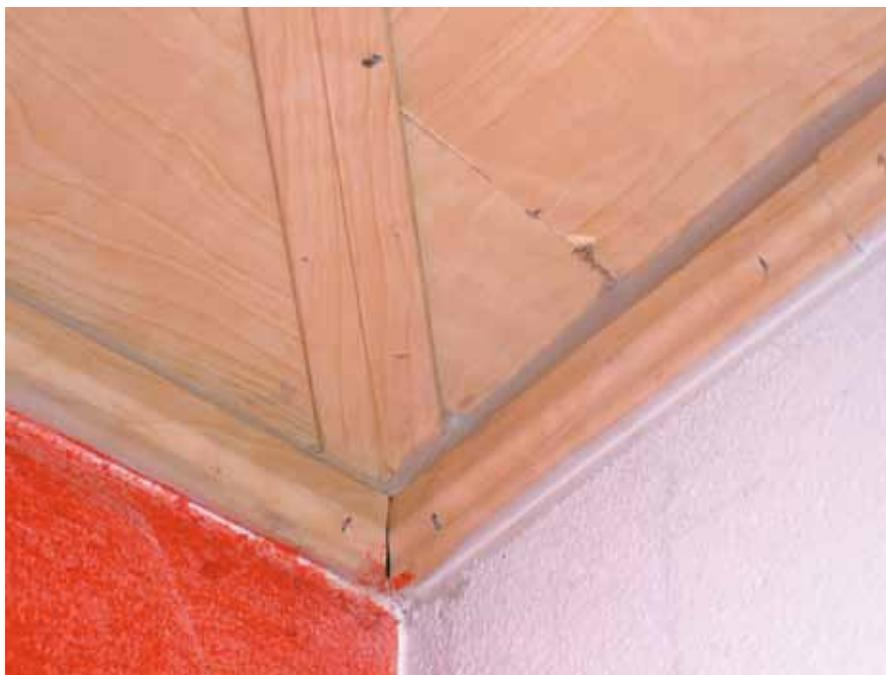
**Abb. 4.24:** Verdächtig: Blendeleisten müssen nicht dick verfugt werden! Hier ist mit größerem Pfusch hinter der Deckenverkleidung zu rechnen.
