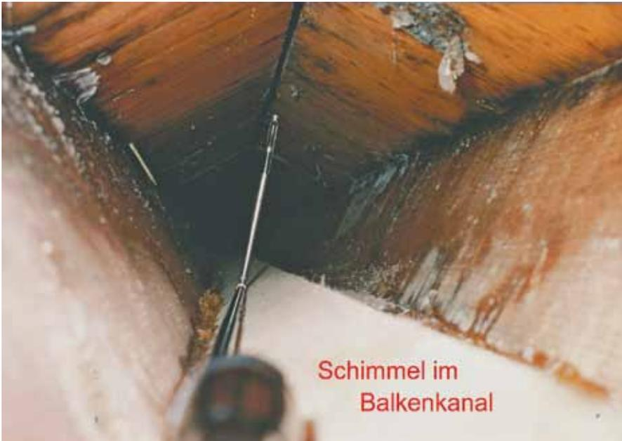
**Abb. 4.57:** Ein konstruktiv entstandener Balkenkanal im First ist durch eindringende feuchte Raumluft im Winter verschimmelt.
