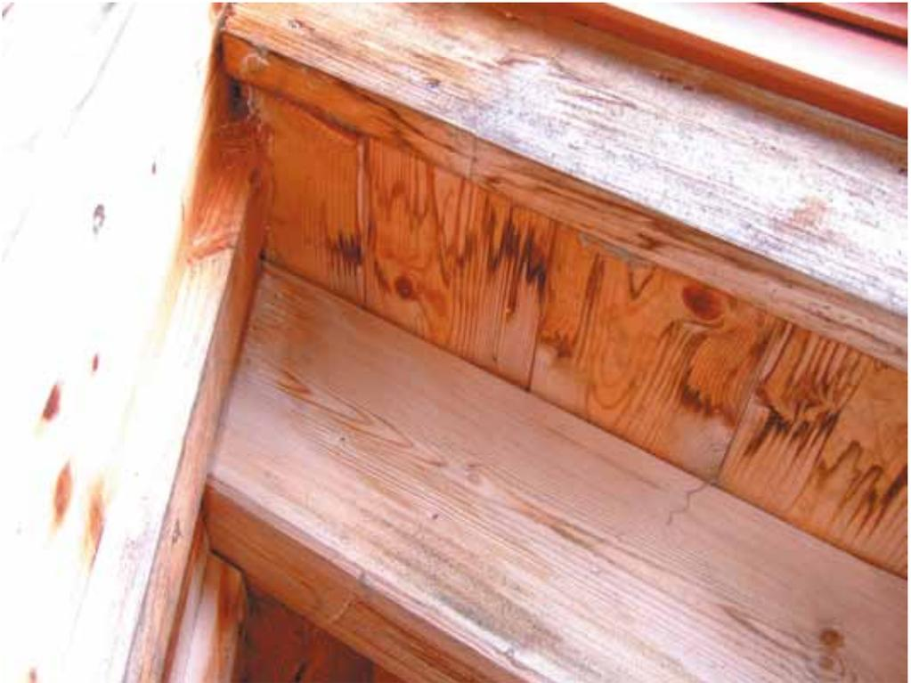
**Abb. 4.53:** Diese Wasserspuren deuten auf Kondensation in der Konstruktion hin.
