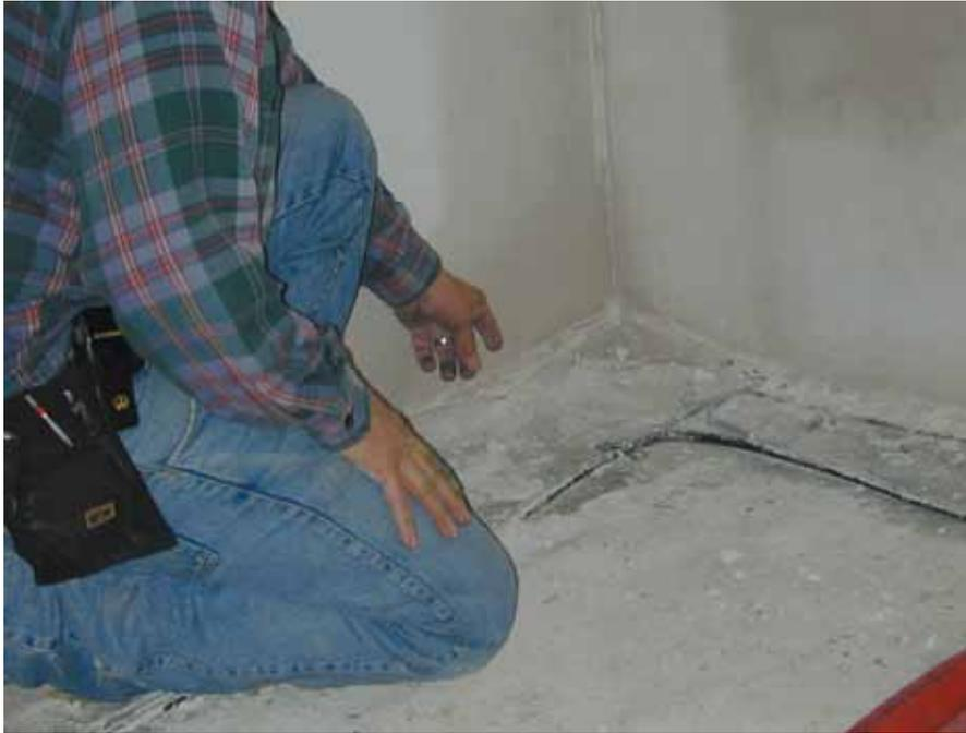
**Abb. 4.10:** So soll es sein: Der Innenputz reicht bis zur Bodenplatte. (Foto: FLiB e. V.)
