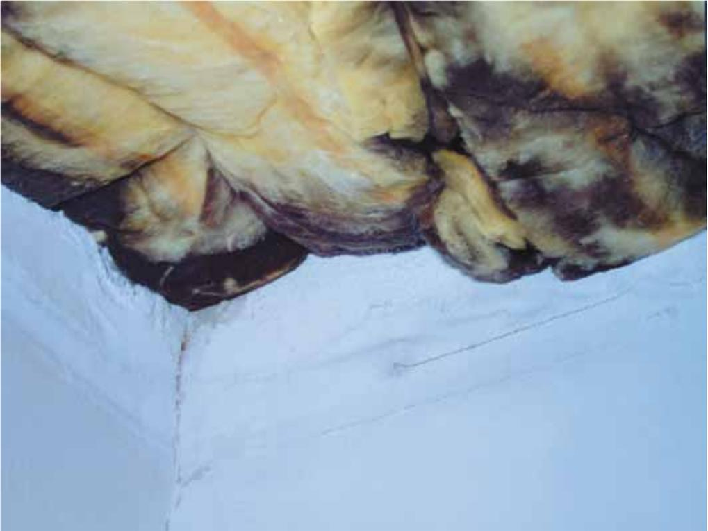
**Abb. 4.62:** Verschimmelte Mineralfaserdämmung, die zutage trat, nachdem die nicht vorschriftsmäßig eingebaute raumseitige Dampfsperre entfernt wurde.
