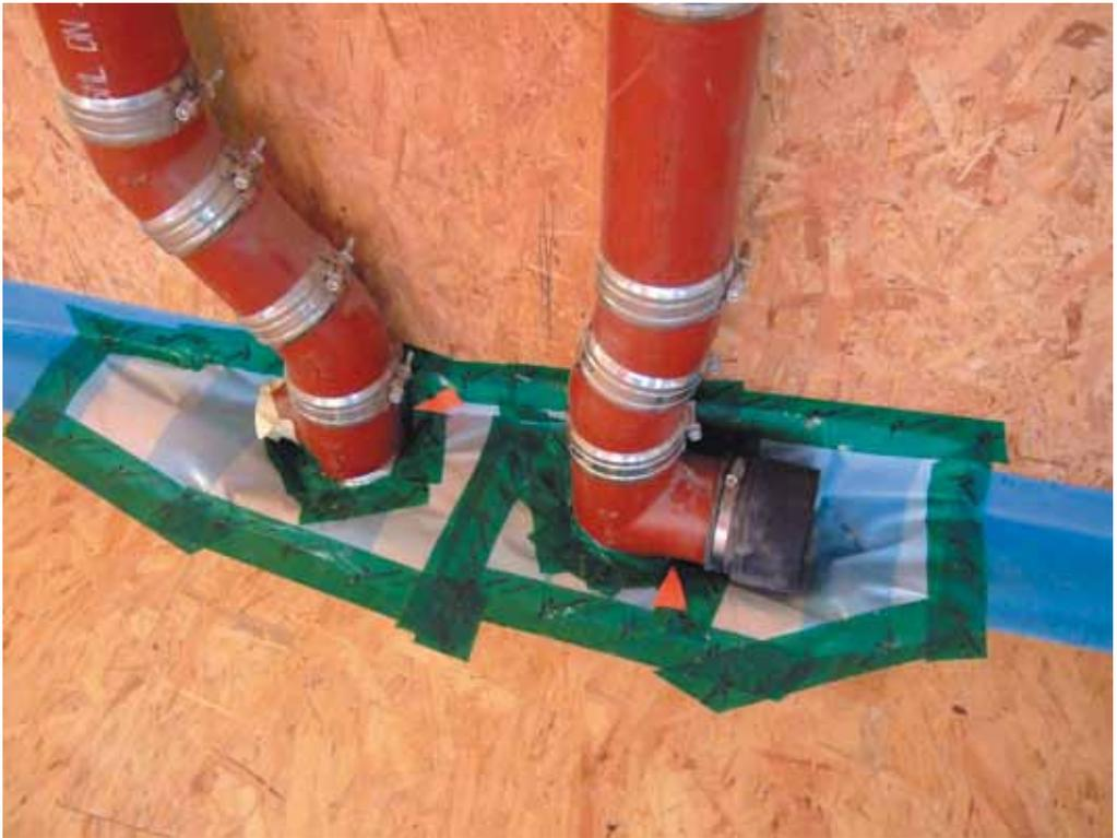
Abb. 4.51: Sorgfältig abgedichtete Rohrdurchführungen durch die Luftdichtheitsebene
