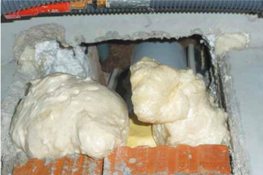
Abb. 4.22: Mislungener Versuch, mit Schaum einen Hohlraum abzudichten.
