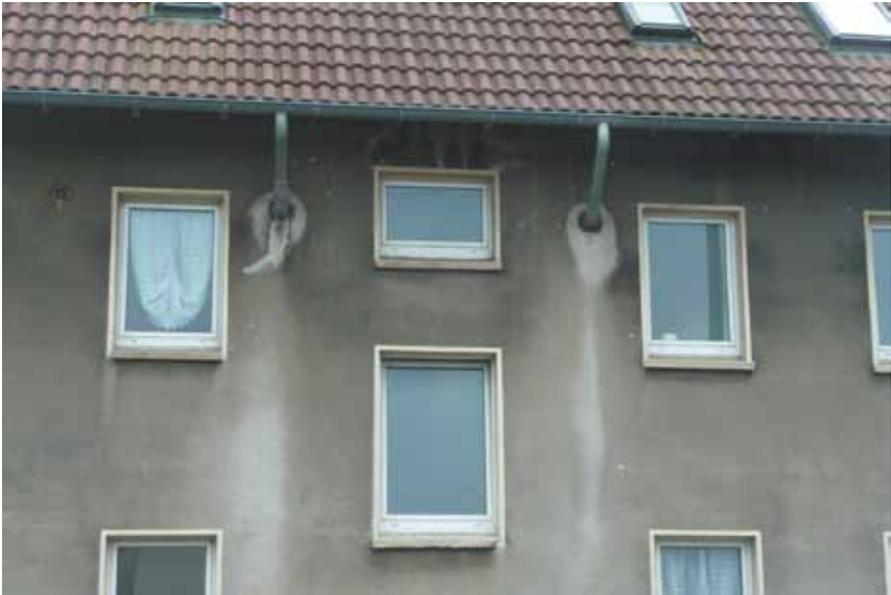
Abb. 4.2: Durch die Fassade geleitete Regenrohre wirken als Wärmebrücke.
