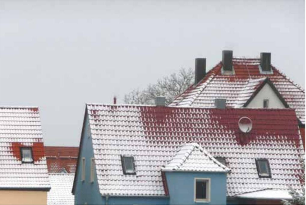
**Abb. 4.7:** Typische deutsche Dachlandschaft oder: wo die Heizenergie verschwindet. Die abgetauten Dachflächen weisen auf unnötigen Mehrverbrauch hin, weil bei Ausführung der Luftdichtheitsebene nachlässig gearbeitet wurde.
