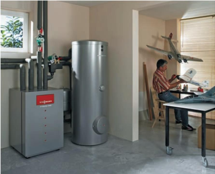
**Abb. 1.10:** Wärmepumpe, die bis zu 65 °C Vorlauftemperatur liefern kann, rechts daneben der Warmwasserspeicher (Foto: Viessmann)
