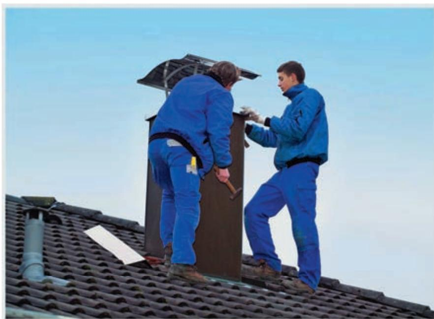
**Abb. 1.9:** Wenn ein Niedertemperatur- oder Brennwertkessel einen Standardheizkessel ersetzt, muss der bereits vorhandene Schornstein an die nun wesentlich niedrigeren Abgastemperaturen angepasst werden. Andernfalls gibt es Feuchteschäden. (Foto: BauSparkasse Schwäbisch Hall)
